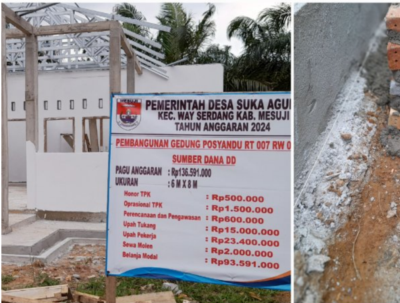
Pembangunan Posyandu Suka Agung Way Serdang
